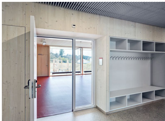
Diese Tür kann beides: automatische Verriegelung beim Szenario Amok, sichergestellter Fluchtweg im Brandfall.
