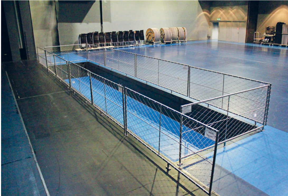
Das leicht handhabbare Geländer gegen Absturz im Saal ist komplett mit elektrischen Kontakten ausgerüstet. Ein Absenken des Transportpodiums ist nur mit eingesetztem Geländer möglich.
