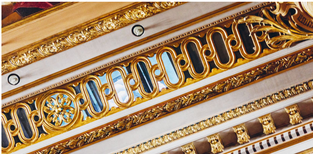
Zwischen den ovalen Verzierungen in der Decke der Grossen Tonhalle verstecken sich die Öffnungen der Entrauchungskanäle.
