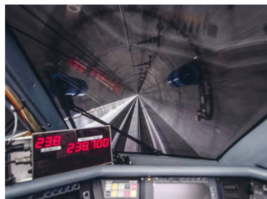
Betriebserprobung auf einer Testfahrt mit einem ICE im Ceneri-Basistunnel.
