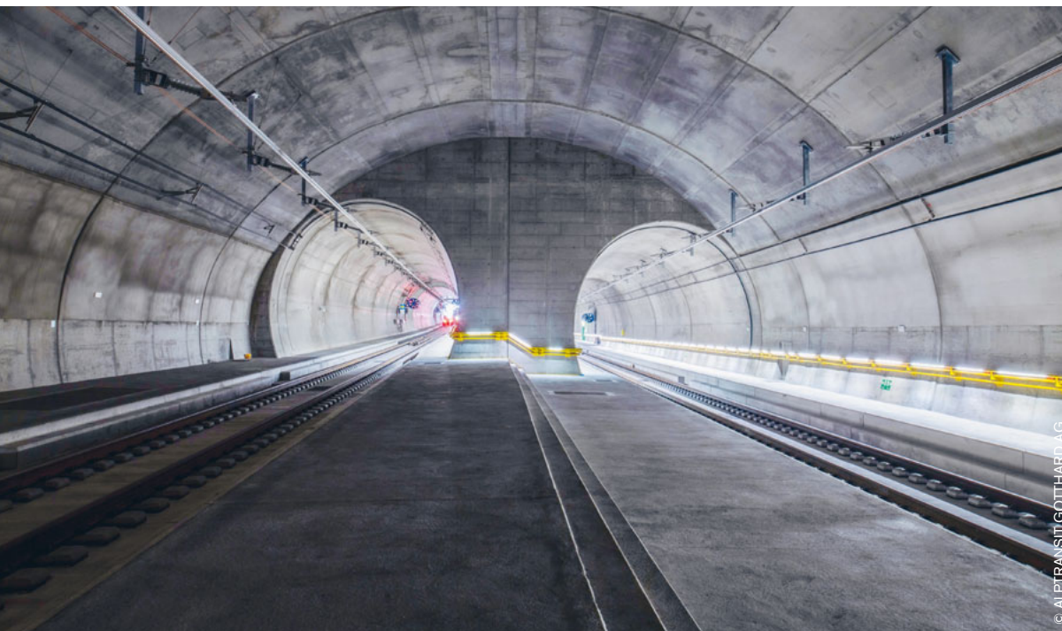
Am Nordportal im Tunnel West des CBT verzweigt sich die Strecke in Richtung Bellinzona und Locarno.
