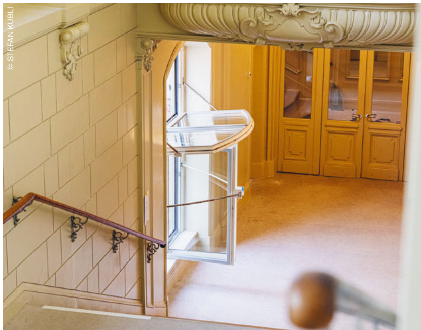
Denkmalgeschützte Türen müssen feuerbeständig und fluchtwegtauglich sein.
