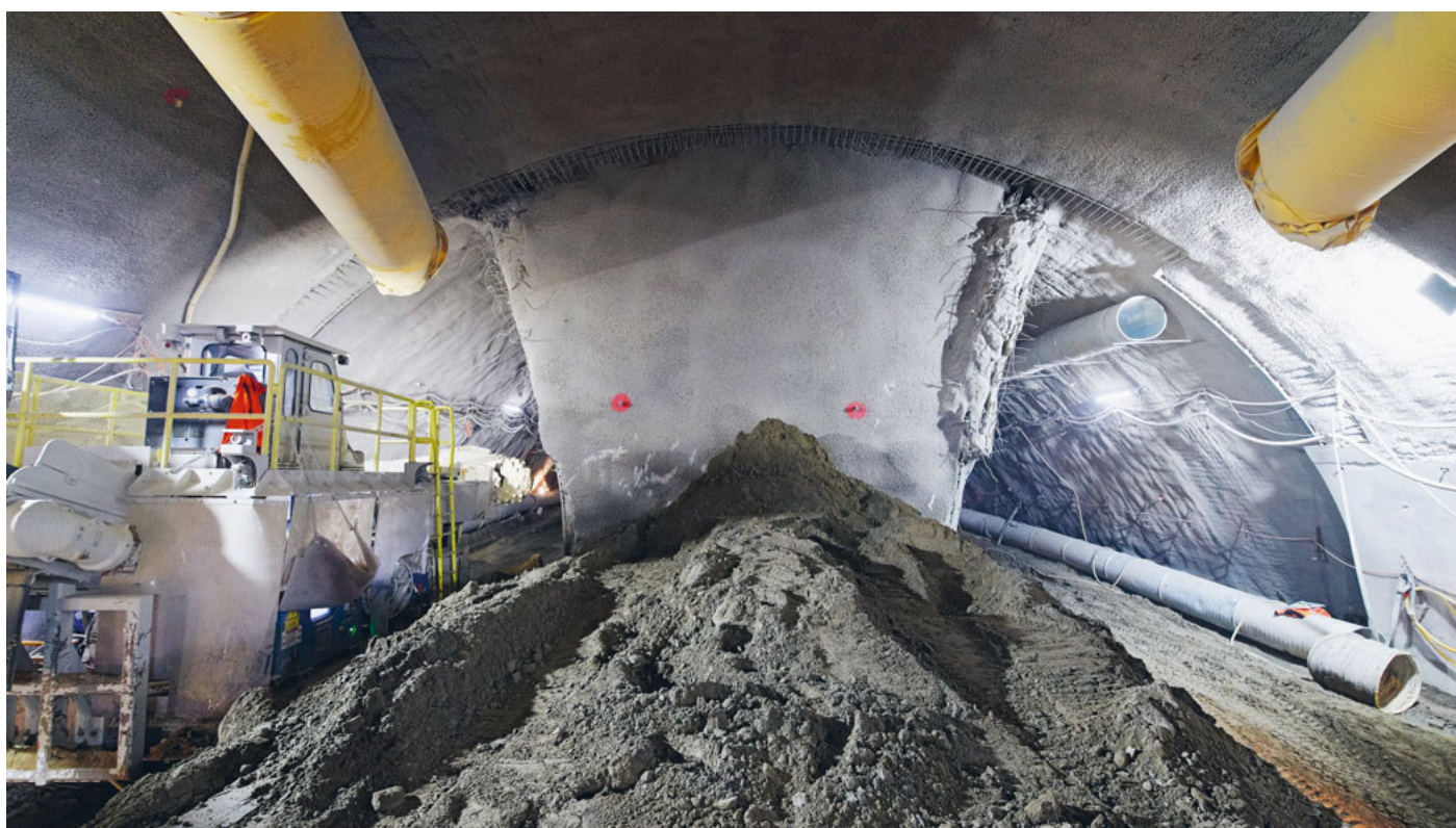
Baustelle Laupenstrasse – Kavernenausbruch, Februar 2022. Foto: Sam Bosshard
