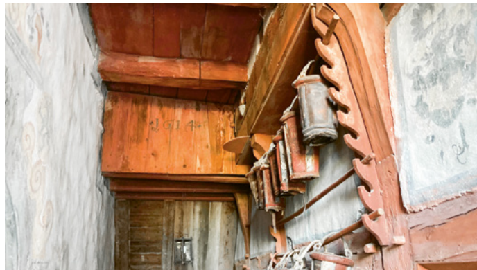
Schloss Hegi: Ob die Löscheimer schon im Einsatz waren? Eine alte Aussenwand wird zur neuen Brandmauer.
