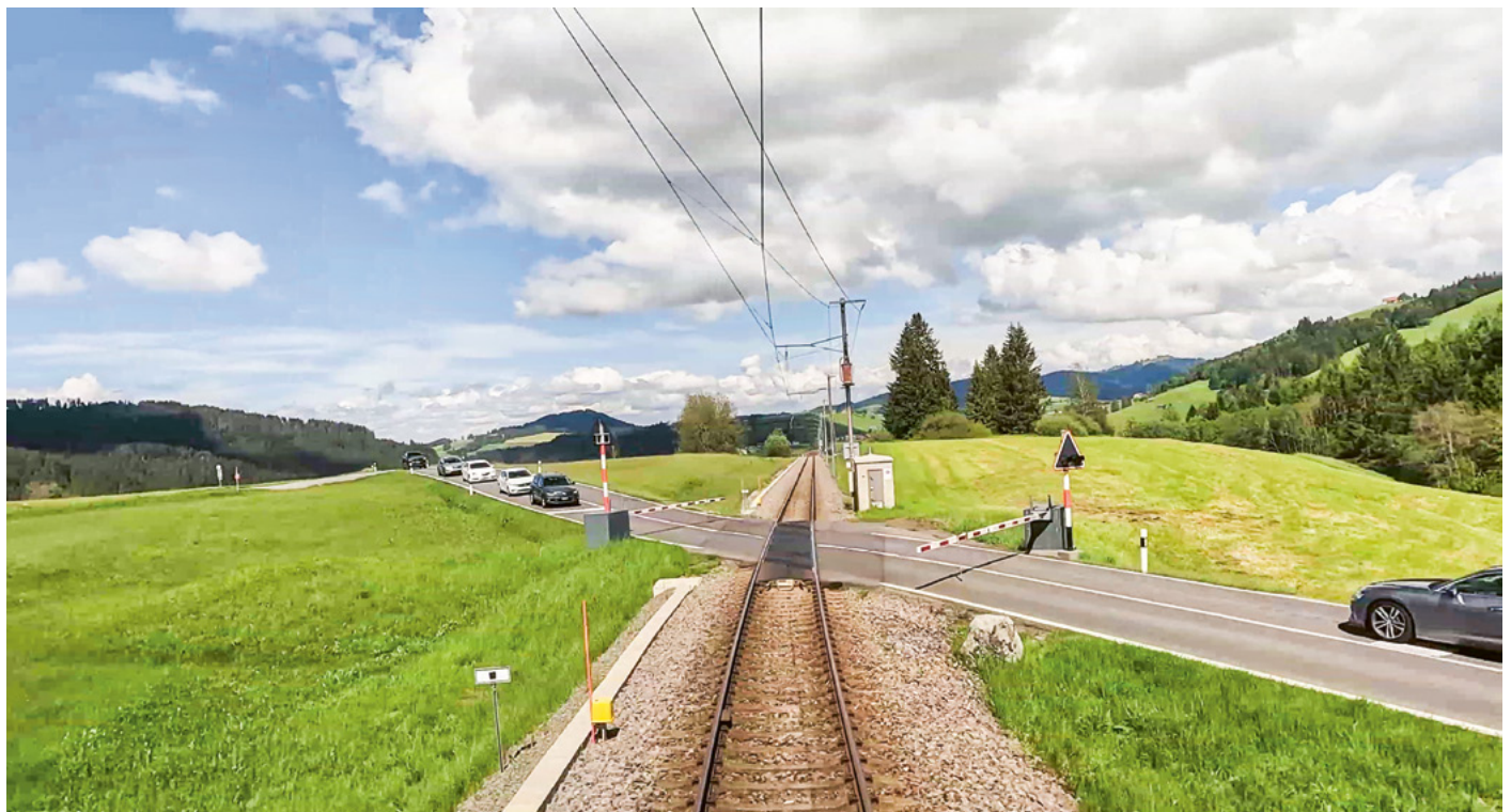
Mit Zugbeeinflussungspunkt gesicherter Bahnübergang Höli 1.
